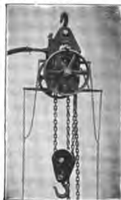
FRICION BRAKE HOIST.
