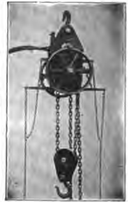
FRICION BRAKE HOIST.
